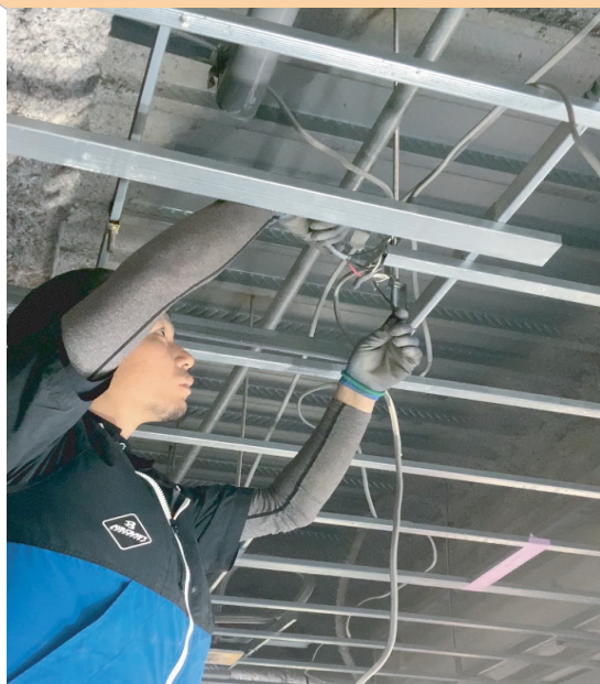
大型店舗改修工事 既存配線
