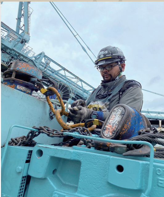
大型機械搬出のために クレーン用吊り具をつけている様子
