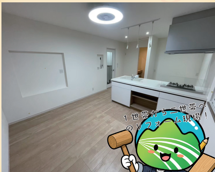
住宅 フルリフォーム 2026年4月竣工
